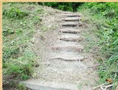
広場への階段、完成！
