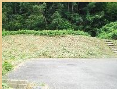
法面除草完了☆
