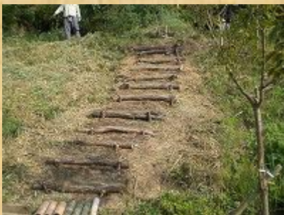
階段設置完了！
