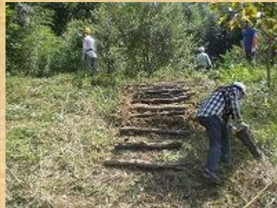
階段設置準備
