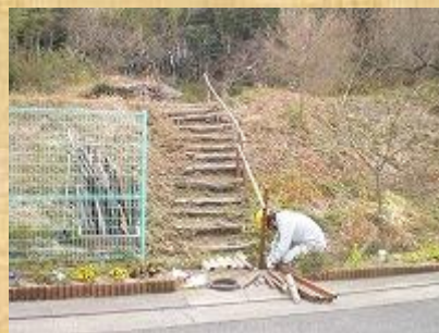
階段手すり設置作業
