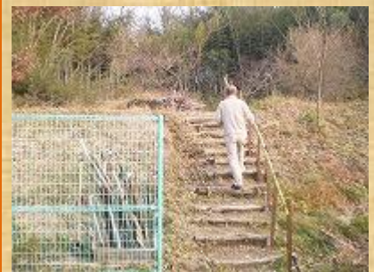
階段手すり完成
