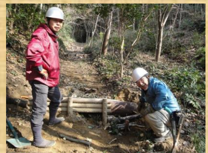
登り道の補修完了
