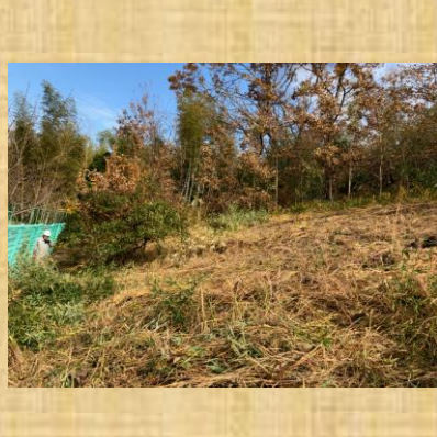
法面の草刈り作業後
