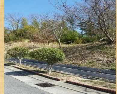
荒らされていない法面
