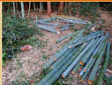
11 道具小屋建設
