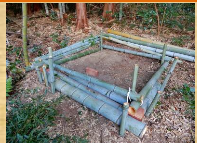
12 道具小屋基礎完了
