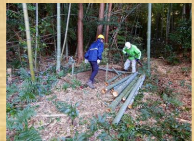
9 道具小屋基礎建設
