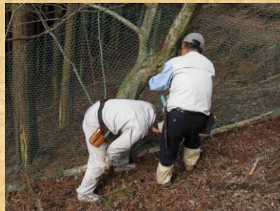
ネットの補修
