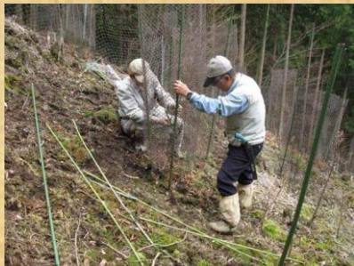
ネットと支柱の補強
